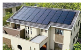
太陽光パネル
