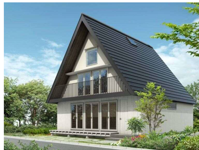
「KURA LOFT」外観
