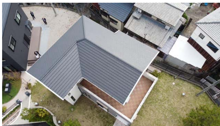
屋根上の空撮画像(全景)
